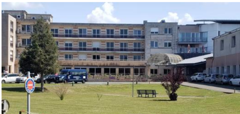
Figure 30 : Hôpital actuel (Centre Hospitalier Caux Maritime)
